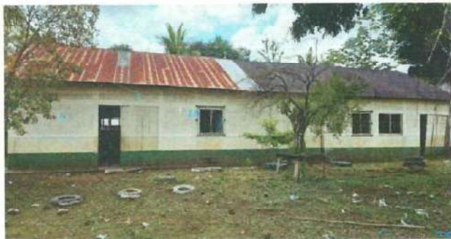
Foto1: Se cambiará el techo de la escuela.
