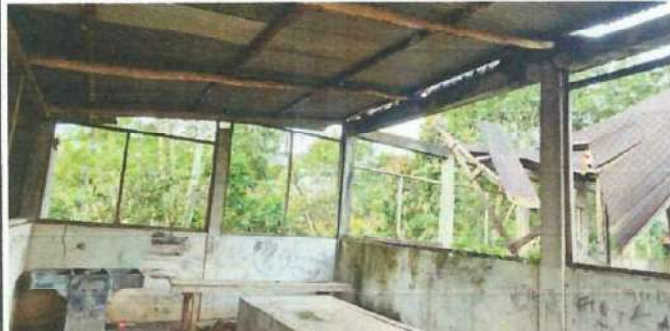
Foto 6: Se colocarán balcones de metal en las ventanas.
