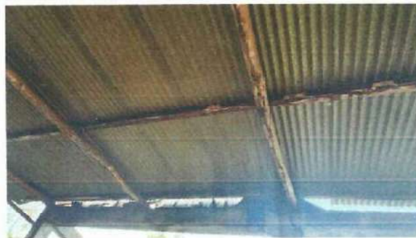
Foto 2: Se cambiará el techo de la escuela.
