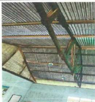
Foto 3: Se cambiará la estructura de madera por metal.
