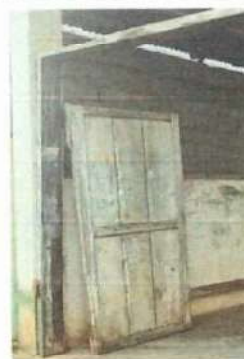
Foto 4: Se cambiará la puerta de madera de la cocina por puerta de metal.
