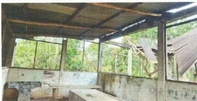
Foto 5: En la cocina se cambiará el techo por estructura metálica y láminas troqueladas.
